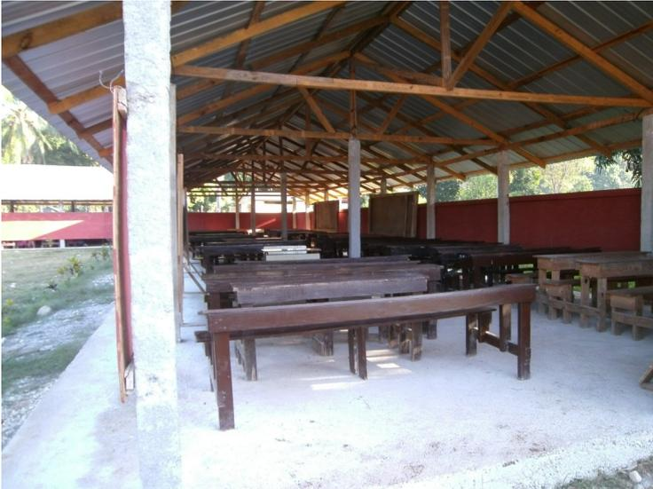
Wiederaufgebauter Hangar — neu mit Betonfundament und -pfeiler
