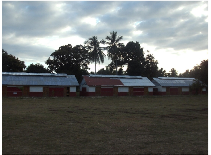
Die drei neuen Klassenzimmer
