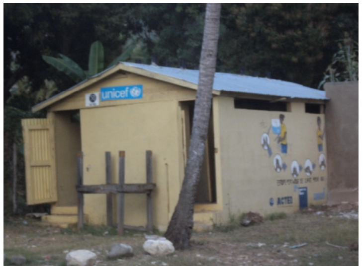
Eine der zwei Toilettenanlagen
